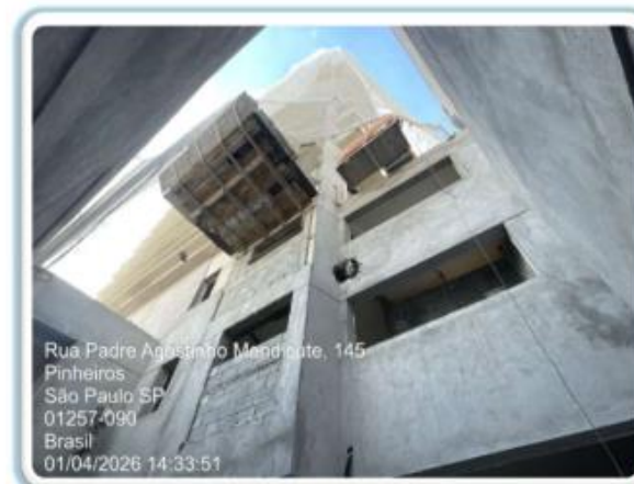
Foto 6 - Fechamento de alvenaria no local de cremalheira
