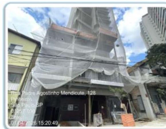
Foto 2 - Fachada do empreendimento
