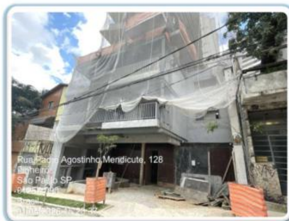
Foto 1 - Fachada do empreendimento
