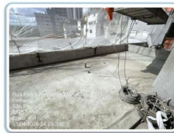
Foto 22 - Laje 3º pavimento
