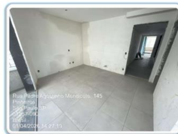
Foto 10 - Instalação de piso
