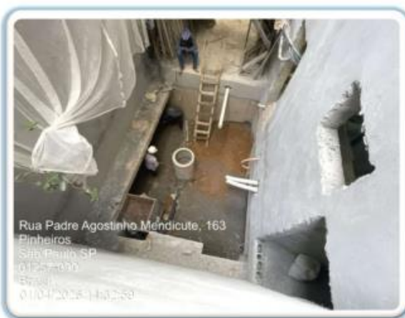
Foto 21 - Fachada externa fundos
