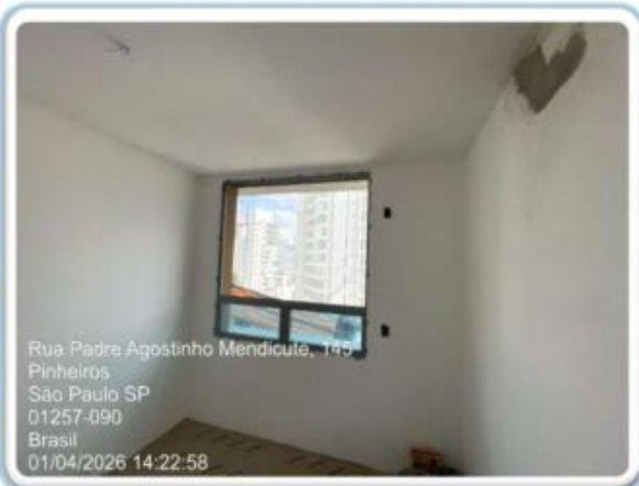
Foto 7 - Apartamento tipo instalação de esquadria
