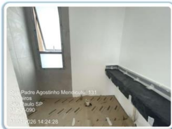
Foto 13 - Apartamento tipo, banheiros em ponto de pintura
