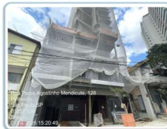
Foto 2 - Fachada do empreendimento
