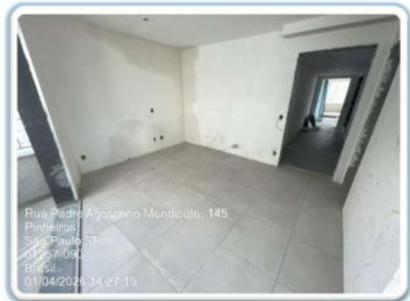
Foto 10 - Instalação de piso
