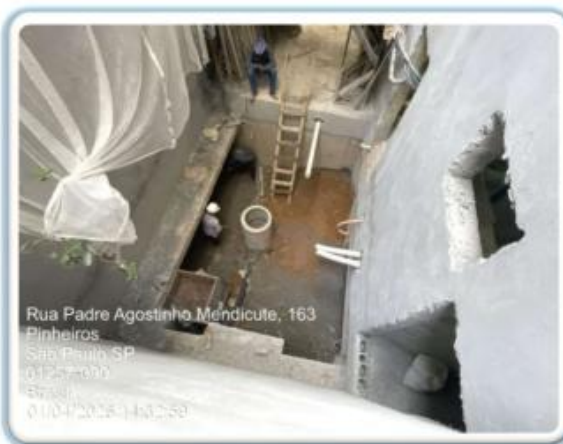
Foto 21 - Fachada externa fundos
