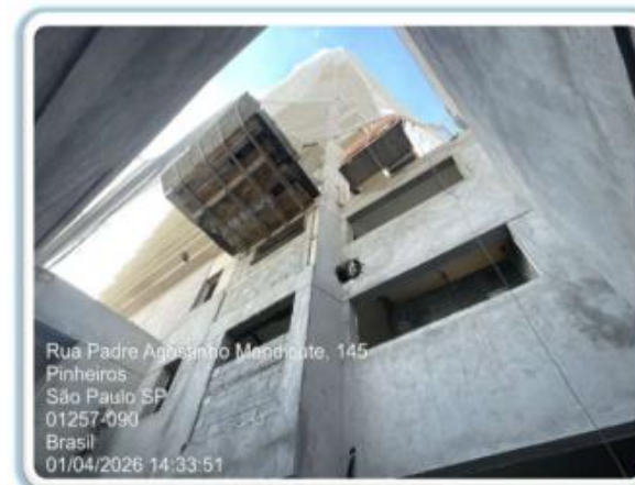
Foto 6 - Fechamento de alvenaria no local de cremalheira
