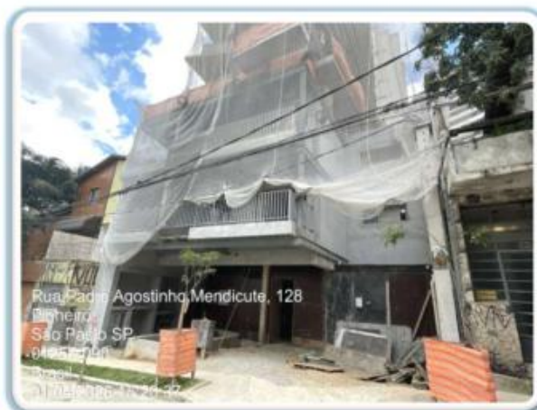
Foto 1 - Fachada do empreendimento
