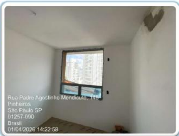
Foto 7 - Apartamento tipo instalação de esquadria
