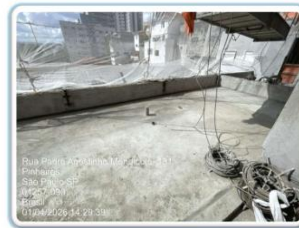
Foto 22 - Laje 3º pavimento
