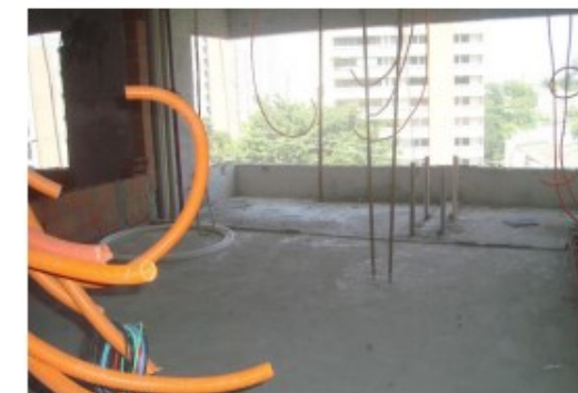
Contrapiso – 10º Pav
