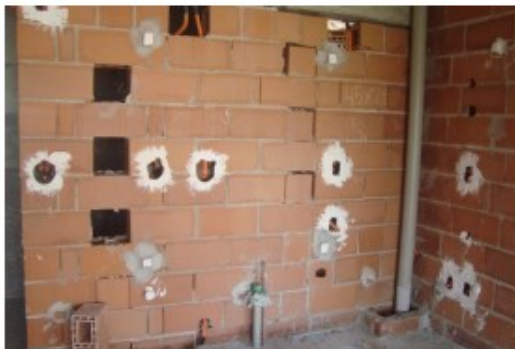
Embutidos em Alvenaria – 12º Pav
