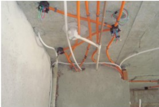
Ramais de Esgoto – 8º Pav
