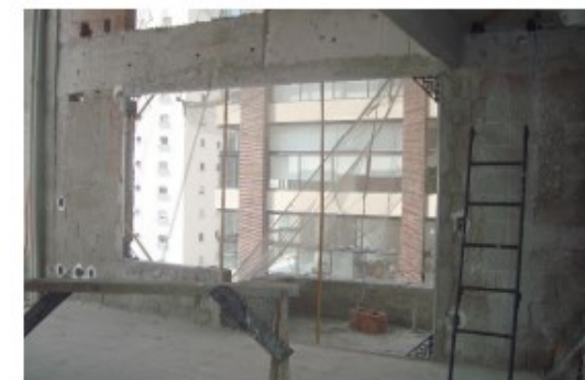
Chapisco Interno – 6º Pav
