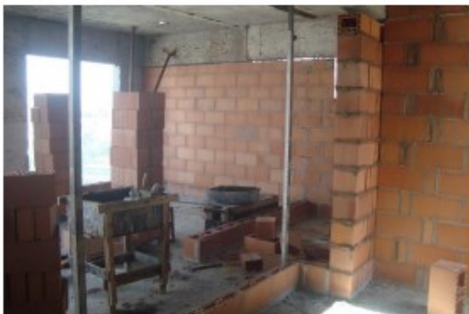
Alvenaria/ Vedação – 20º Pav
