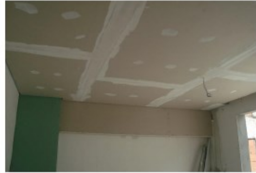
Forro de Gesso – 3º Pav
