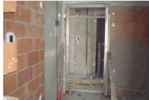
Batente Porta Corta Fogo – 7º Pav
