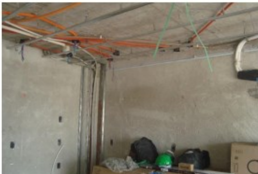
Reboco Interno – 4º Pav
