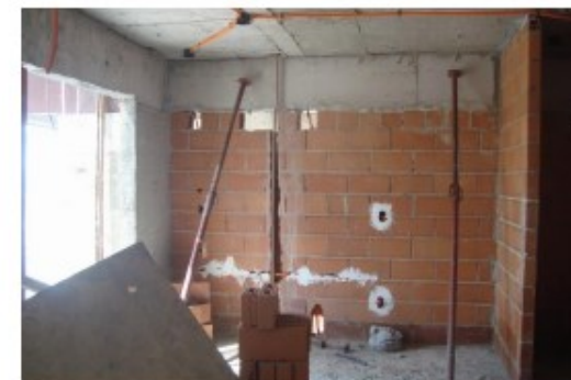
Embutidos em Alvenaria – 17º Pav
