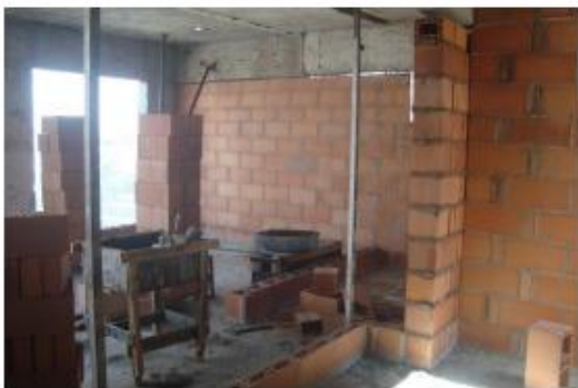
Alvenaria/ Vedação – 20º Pav
