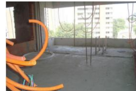
Contrapiso – 10º Pav
