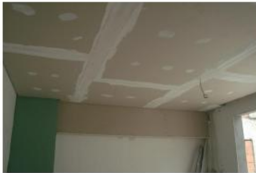
Forro de Gesso – 3º Pav
