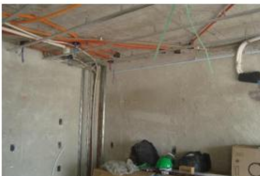
Reboco Interno – 4º Pav
