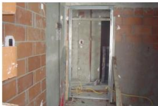
Batente Porta Corta Fogo – 7º Pav
