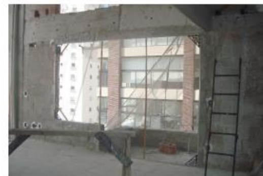
Chapisco Interno – 6º Pav
