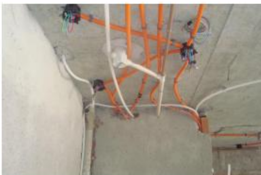
Ramais de Esgoto – 8º Pav
