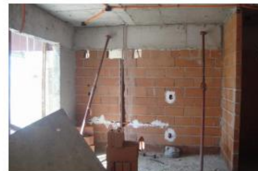
Embutidos em Alvenaria – 17º Pav
