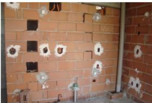
Embutidos em Alvenaria – 12º Pav
