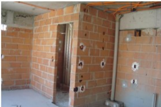
Prumadas Hidráulicas – 14º Pav
