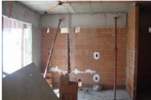
Embutidos em Alvenaria – 17º Pav
