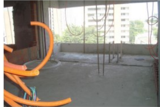
Contrapiso – 10º Pav
