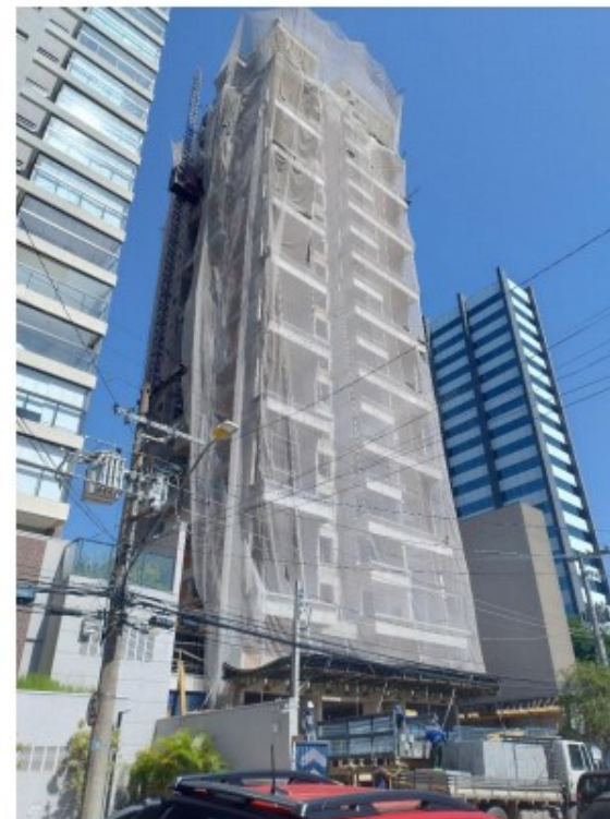
Vista da Fachada Lateral
