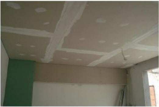
Forro de Gesso – 3º Pav
