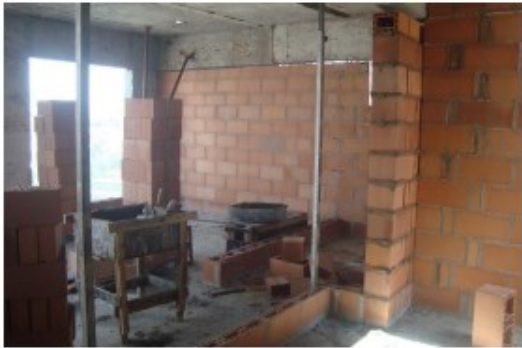
Alvenaria/ Vedação – 20º Pav
