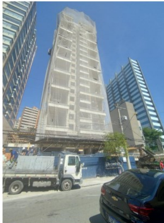
Vista da Fachada Frontal
