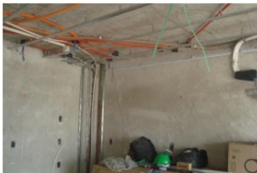
Reboco Interno – 4º Pav
