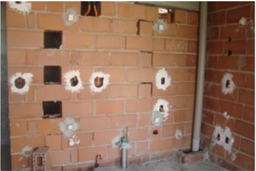
Embutidos em Alvenaria – 12º Pav
