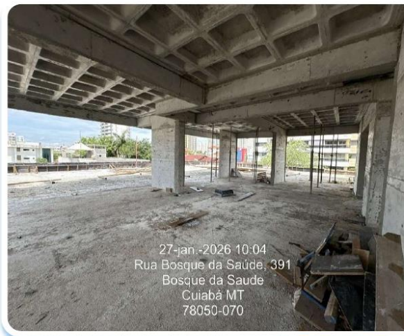
Foto 4 - Laje do 1º sobressolo
