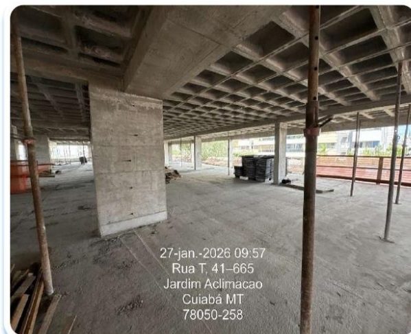
Foto 1 - Laje do 1º sobressolo.
