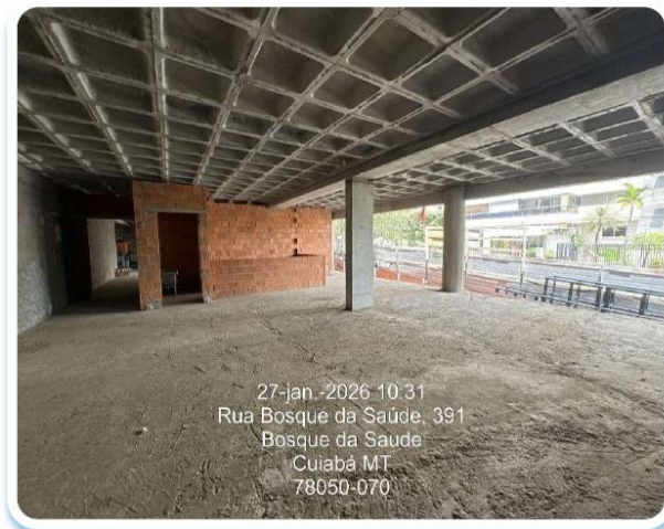
Foto 7 - Alvenaria Pavimento térreo.
