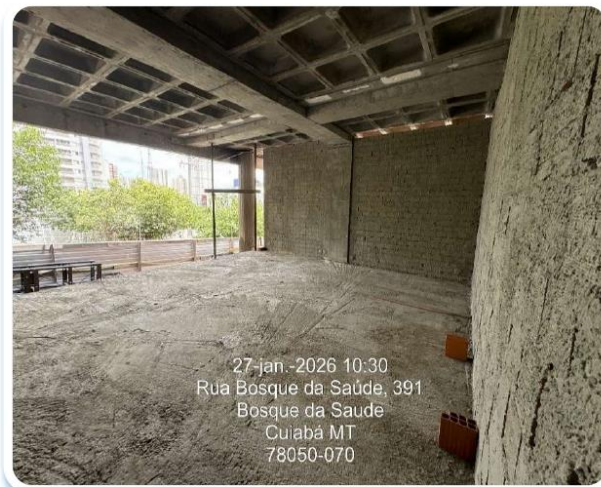
Foto 5 - Chapisco pavimento térreo.
