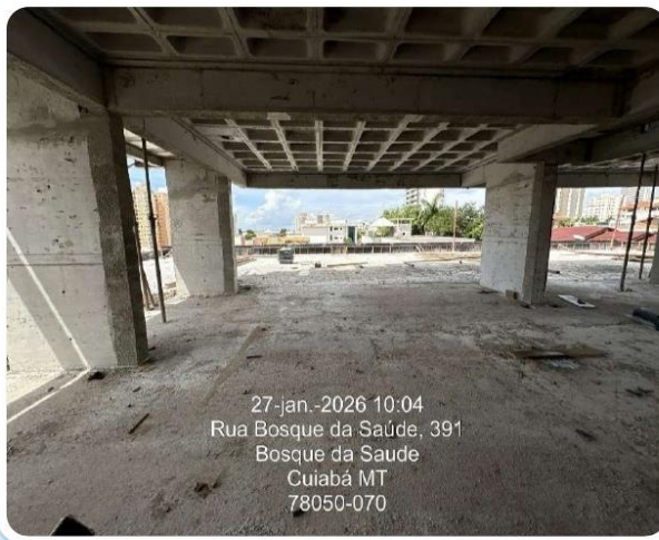
Foto 3 - Laje do 1º sobressolo.
