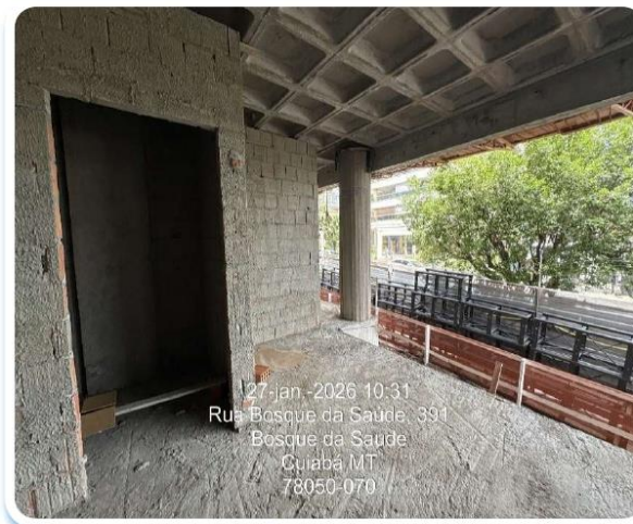
Foto 6 - Chapisco pavimento térreo.
