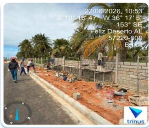
Foto 7 - Muro de Fechamento
