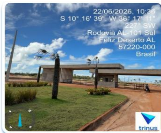
Foto 1 - Acesso de obra
