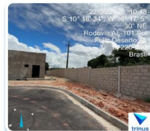
Foto 4 - Muros de Fechamento
